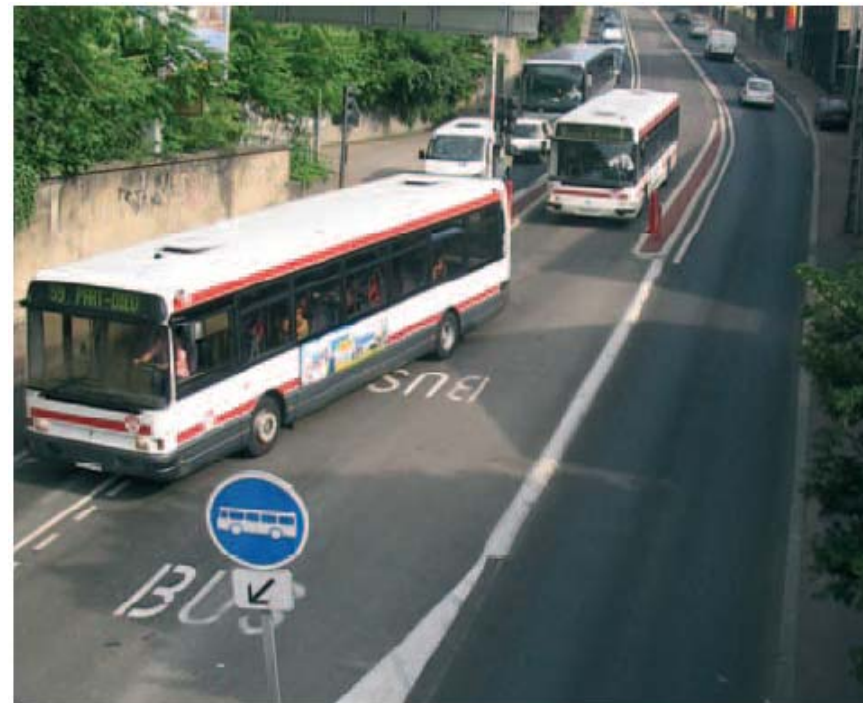
Lyon, sortie du site propre réversible de la future ligne C1 – Source Certu
