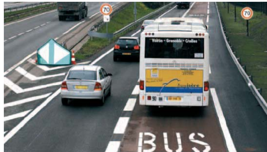
Grenoble, expérimentation d'une voie réservée sur A48 – Source Conseil Général 38
