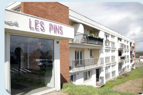
Les Pins - Pont-de-l'Arche
