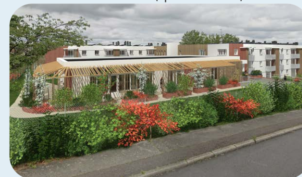
Les Pins - Pont-de-l'Arche (après rénovation)
