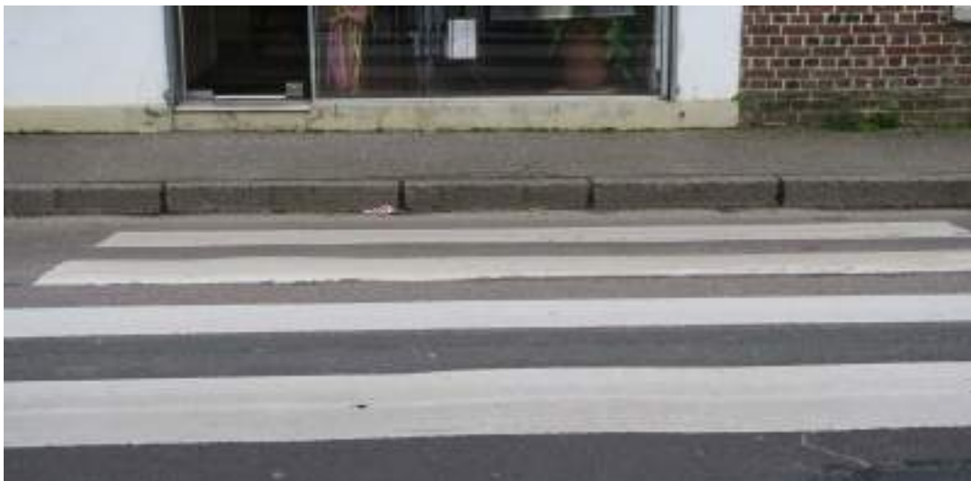
Absence de décaisse à Bourg-Achard
